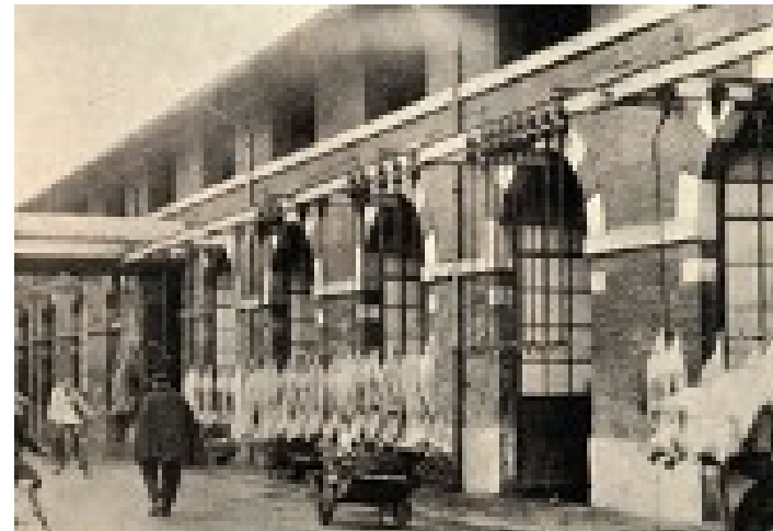
Réhabilitation des abattoirs de Saint-Cyprien à Toulouse
