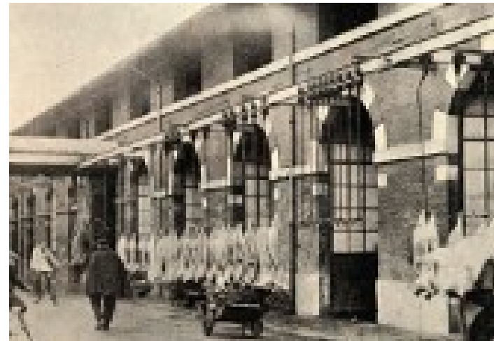
Réhabilitation des abattoirs de Saint-Cyprien à Toulouse
