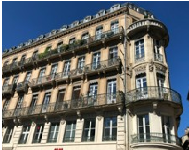
Allée Jules Guesde à Toulouse après les travaux de réhabilitation
