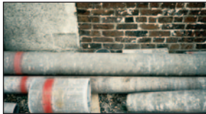
© INRS Canalisation en amiante ciment
