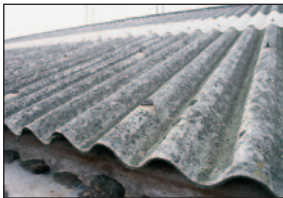
© INRS Toiture en amiante ciment
