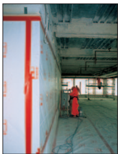
© INRS Chantier de désamiantage
